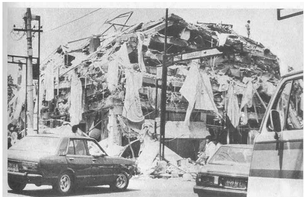
Terremoto di Città del Messico (Settembre 1985). Le strutture portanti di questo edificio sono state falciate dagli sforzi di taglio causati dal sisma ed i piani sono caduti uno sull'altro. (Cortesia de Il Tempo).
